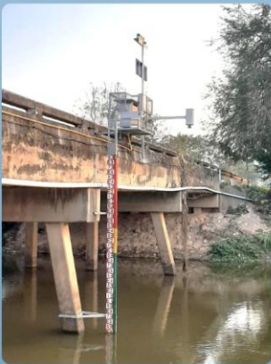
สถานีเตือนภัยด้วย ปริมาณน้ำฝนและระดับน้ำ
